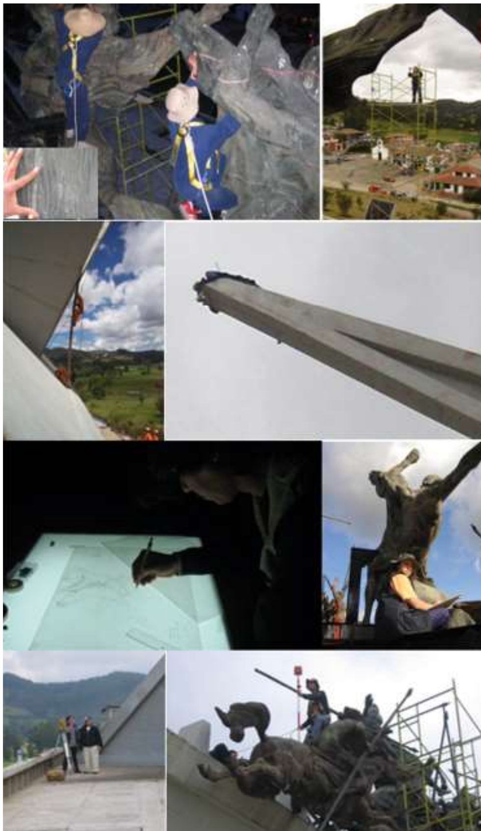
Figura 5. Monumento a los lanceros, (1) trazado de niveles horizontales y verticales con nivel láser, (2) Registro fotográfico de flancos (3 y 4) toma fotográfica superior, (5 y 6) dibujo de los flancos internos, (5 y 6) Levantamiento topográfico. Fotografías Mayorga 2006. Figure 5. Monument to the lanceros, (1) horizontal and vertical levels drawn with laser level, (2) photographic record of flanks, (3 and 4) upper photographic shot, (5 and 6) drawing
