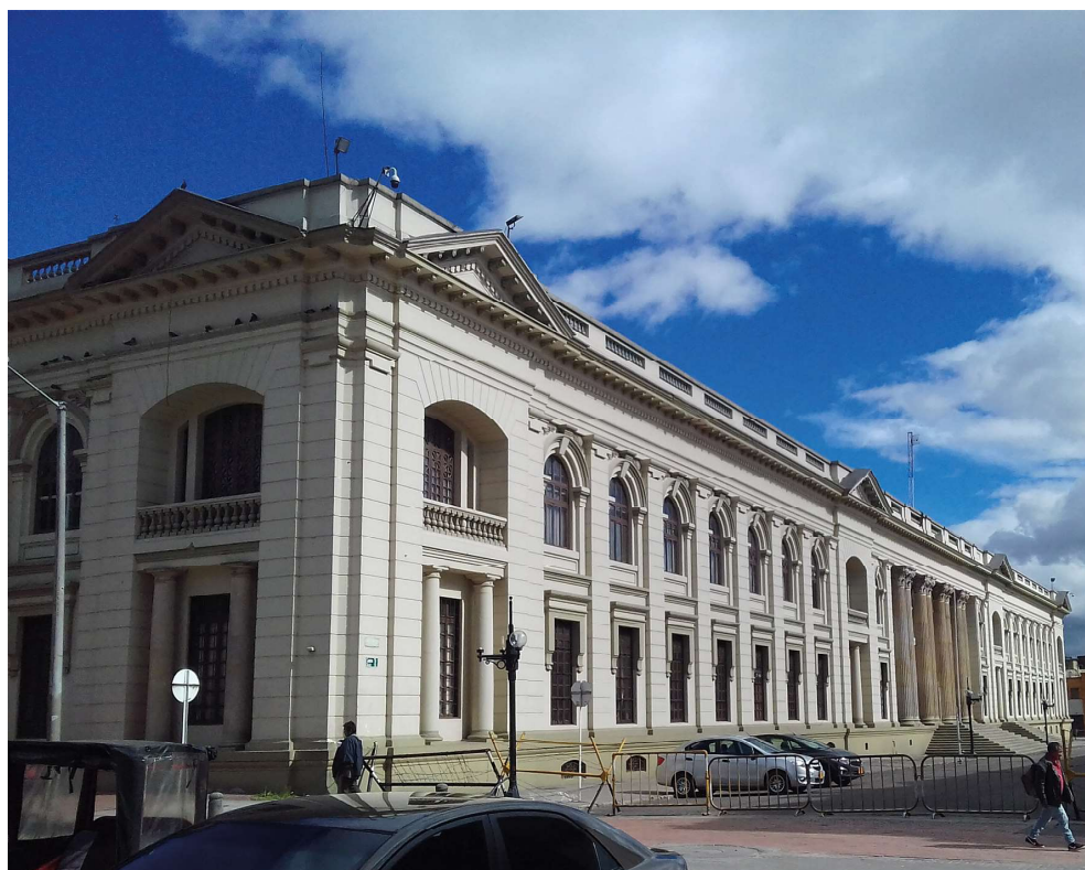
Figura 1. Fachada occidente del edificio de la escuela de Medicina. Corresponde a la solución final propuesta por la firma Herrera, Casanovas y Manheim en 1931. Fuente. Elaboración propia, 2019.
