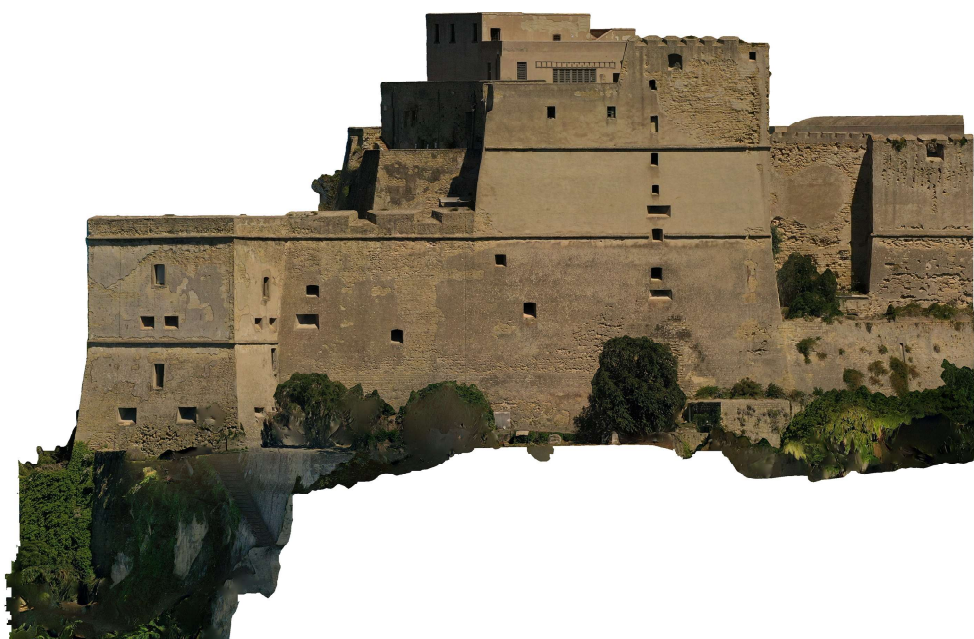
Figura 4. Levantamiento del 2020. Ortoproyección de elevación a partir de nubes de puntos image-based modeling. Imagen de los autores.
